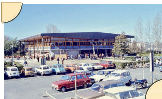
Restaurant universitaire Cap Sud, vue extérieure (~1970)
