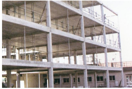
FIGURE 19: Bâtiment de type poutre poteau
