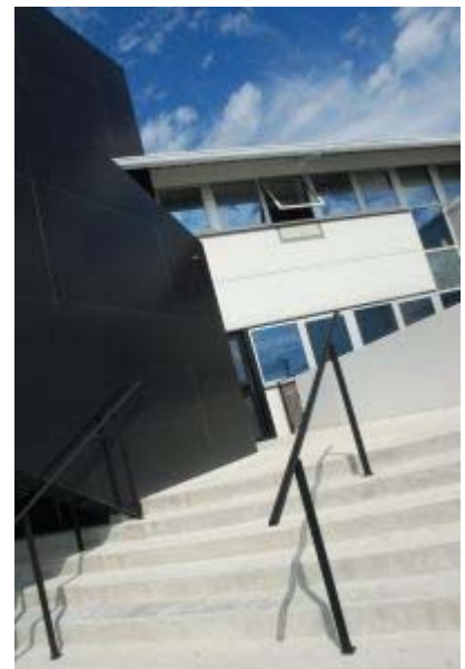
Pépinière d'entreprises d'Artix - Réseau des pépinières d'EUROLACQ
